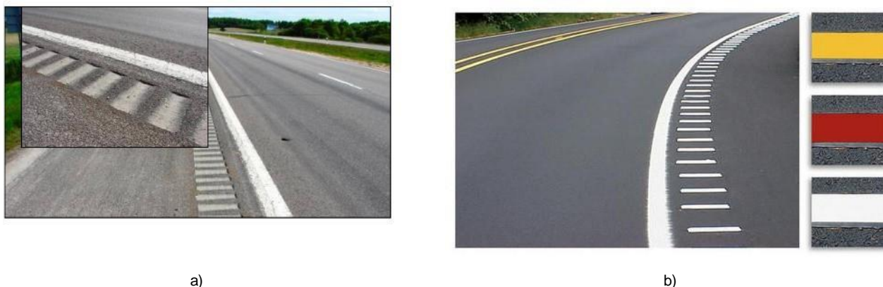
Figura 5-8. a) bandă sonoră frezată; b) bandă sonoră termoplastică
